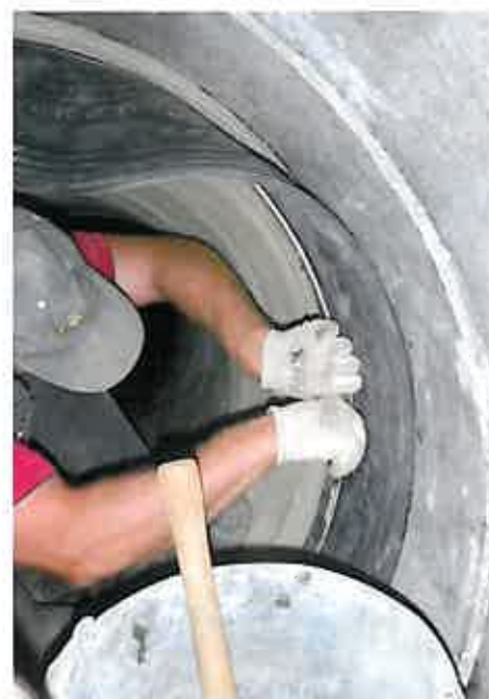
Ausgehend vom neuen GFK-Rohr wurde ein stufenloser Übergang vom GFK-Rohr DN800 zum Betonrohr DN1000 geschaffen.
