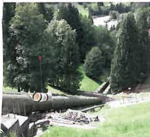
Die zu sanierende Leitung überwindet einen Höhenunterschied von 62 Metern.
