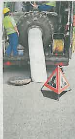
Rabmer Bau setzt verstärkt auf Südosteuropa
