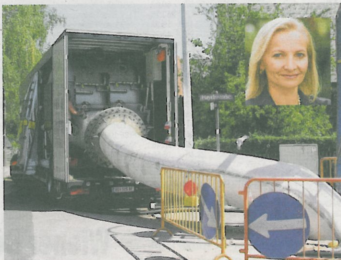
Mit der grabungsfreien Rabmer-Methode können 150 Meter Rohrleitung täglich saniert werden. Fotos: Rabmer Bau
