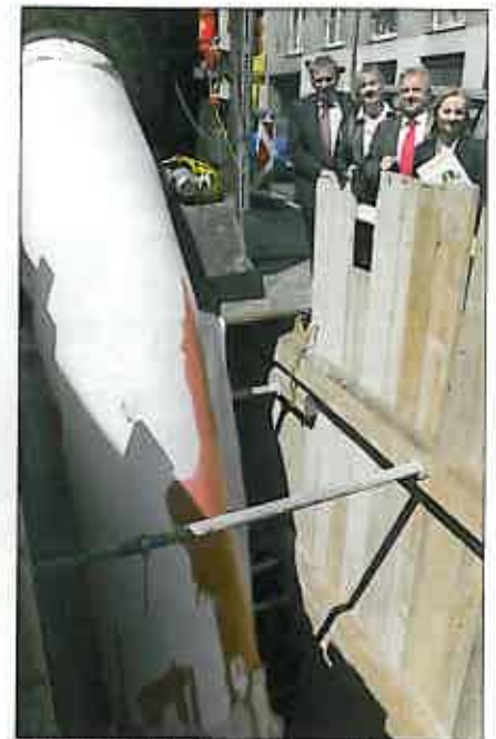
DI Hans Sailer, Leiter Wiener Wasserwerke, Dr. Ute Boccioli, Geschäftsführerin ÖGL, DI Robert Selinger, Vorsitzender des Vorstandes ÖGL und Ulrike Rabmer-Koller, Rabmer-Geschäftsführerin auf der Baustelle.
