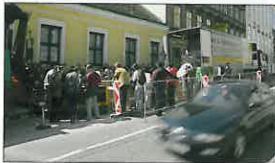
Die Baustelle Barawitzkagasse – durch die grabenlose Leitungssanierung bleiben Straßen weiterhin befahrbar und der Verkehr fließt.
