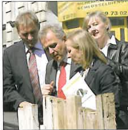
Baustellenbesichtigung durch ÖGL-Expertinnen
