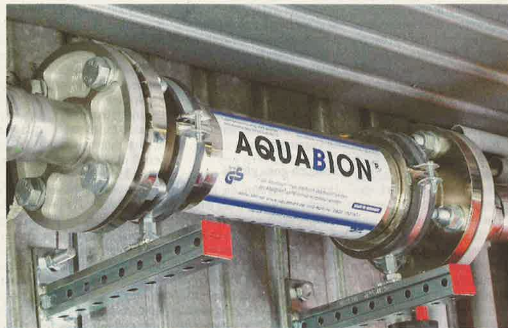
AQUABION® Kalk- und Korrosionsschutz für eine Kühlwasserleitung
