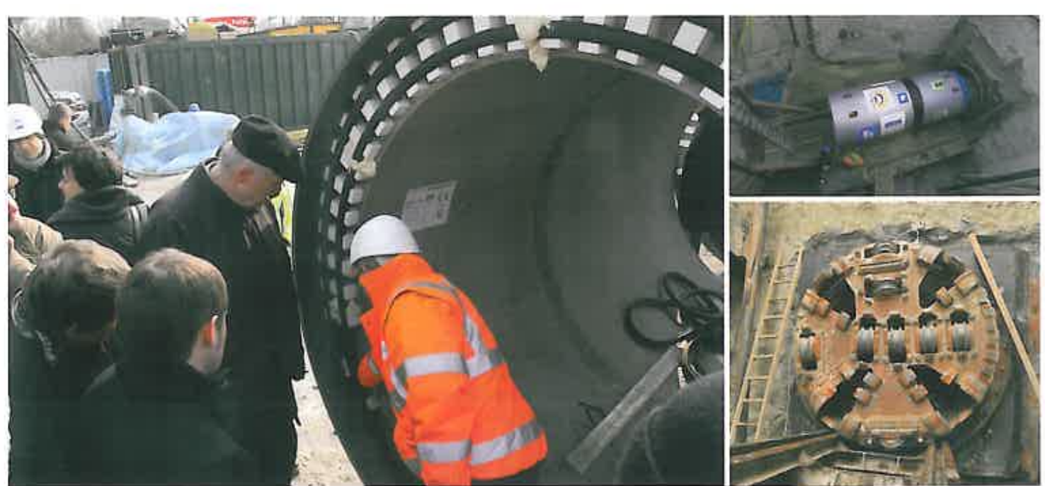
Im Rahmen einer Info-Veranstaltung konnten technisch interessierte Besucher auf der Baustelle des ASKE die Hydraulische Fuge in Augenschein nehmen. Rechts oben: Blick in den Startschacht zu Beginn des Projekts, darunter die im Zielschacht eingefahrene Vortriebsmaschine.
