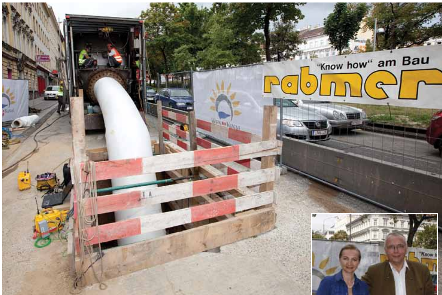
Kanalsanierung am „Lerchenfelder Gürtel“ mittels Schlauchliner-Verfahren
