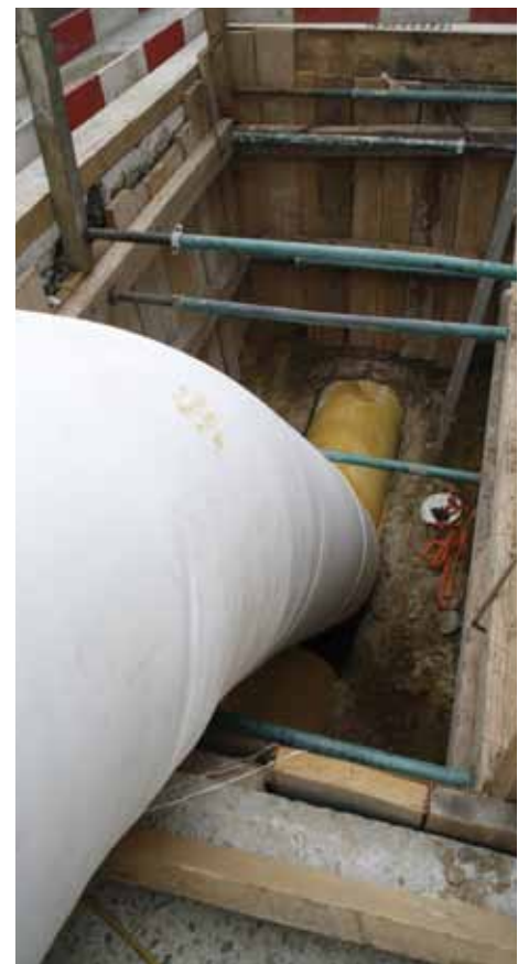
Unter Druck wird in die bestehende Leitung der Schlauchliner „hineinreversiert“ bzw. eingestülpt und mit Erreichen des Leitungsendes so lange mit Heißdampf geheizt, bis das Epoxydharz ausgehärtet ist und sich mit dem Altrohr verklebt hat
