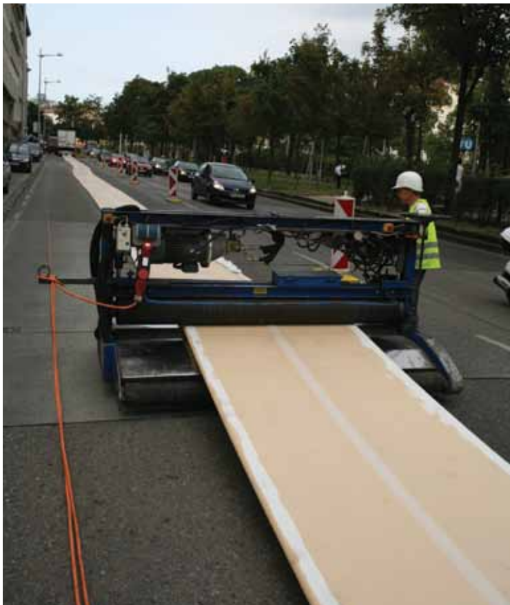
Tränken des 100 m langen Schlauchliners auf der Außenseite mit Epoxydharz
