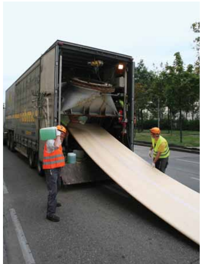
Einbringen des Schlauchliners in die Reversionstrommel
