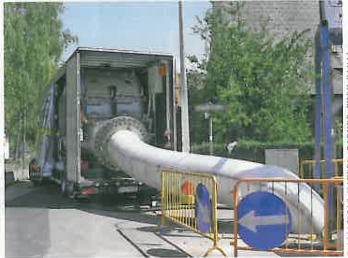
Praxis: Installation eines Liners über einen bestehenden Schacht ohne jegliche Aufgrabung
