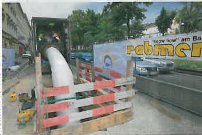
Grabenloses Rohr- saniierungsprojekt – Wien, Lerchenfelder Gürtel
