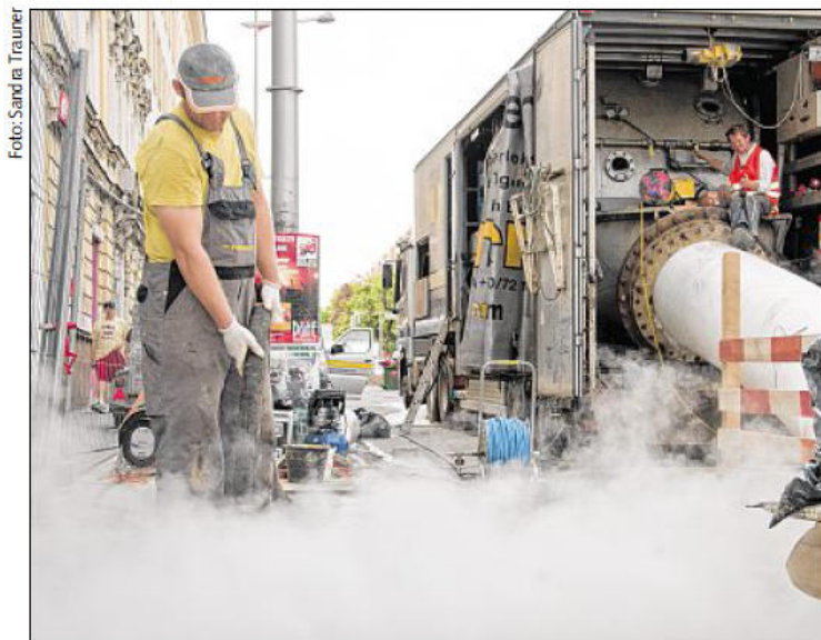
Es dampft: Am Gürtel wird ein alter Kanalabschnitt abgedichtet
