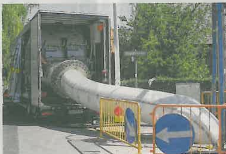
Grabenlose Sanierung durch Schlauchliner der Firma Rabmer.
