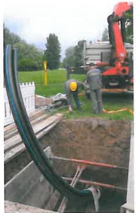
Die Gesamtlänge des Leitungsabschnitts von 2500 m wird in nur 14 Abschnitten saniert.
