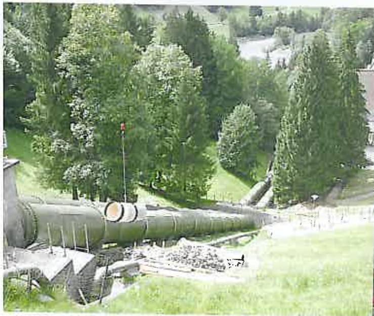
Sanierung der Leerlaufleitung.
