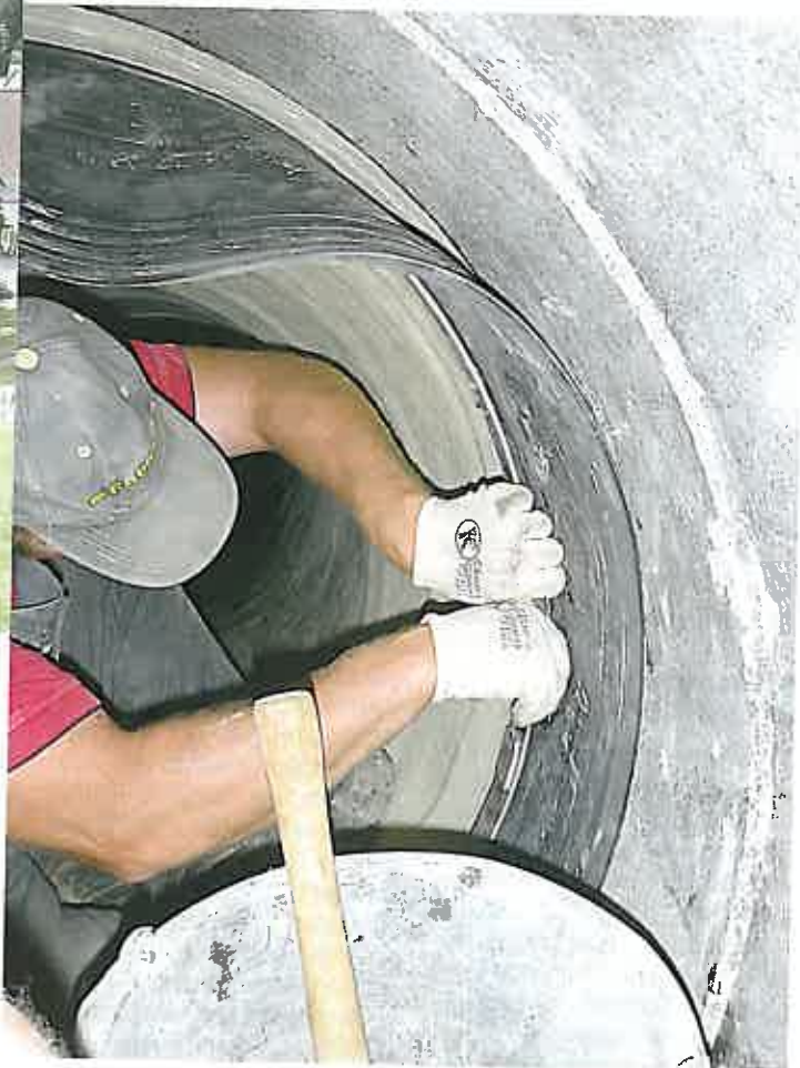
Sanierung der Leerlaufleitung.
