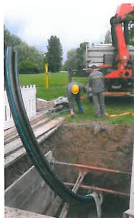
Die Gesamtlänge des Leitungsabschnitts von 2500 m wird in nur 14 Abschnitten saniert.
