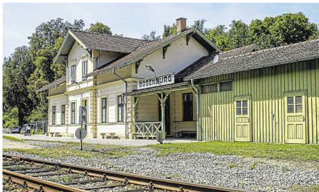
Das denkmalgeschützte Gebäude wird barrierefrei.
